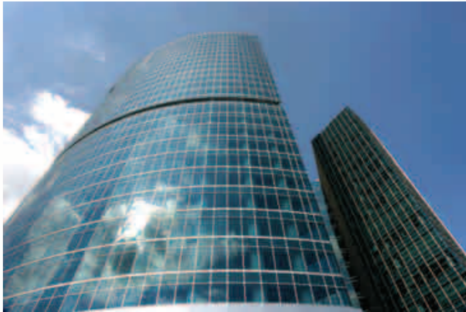
Naberezhnaya Tower, Building B (29,000 sqm) Башня на Набережной, здание В (29 000 кв.м) Procter & Gamble - 8,000 sqm Citibank - 4,700 sqm
