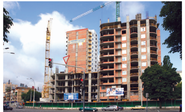
Офисно-жилой комплекс, ул. Копиленко, 8
