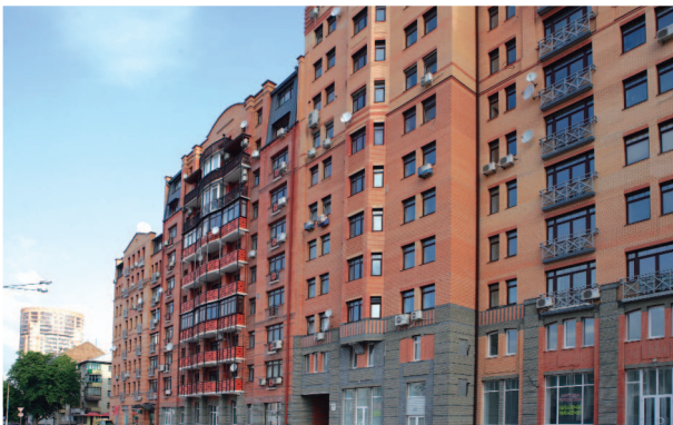
Офисно-жилой комплекс, ул. Панаса Мирного, 12
